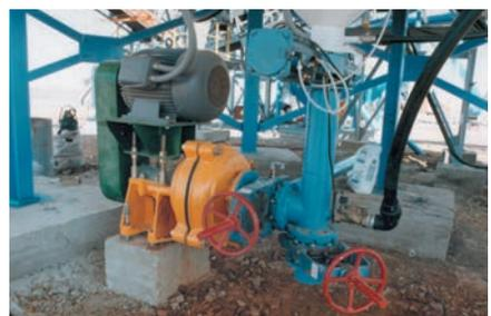
Sistema de descarga lodos bajo tanque
