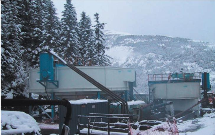
Clarificadores 12 m y 6 m Ø en perforación de túneles
